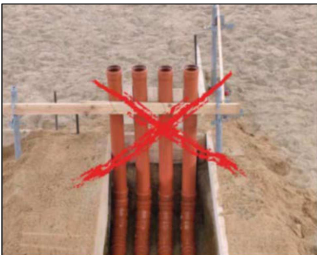
Abbildung 14: keine zulässige Einführung [1]
