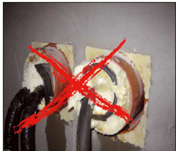
Abbildung 15: keine zulässige Abdichtung [1]
